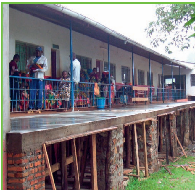
Ampliamento della sala di aspetto del poliambulatorio
