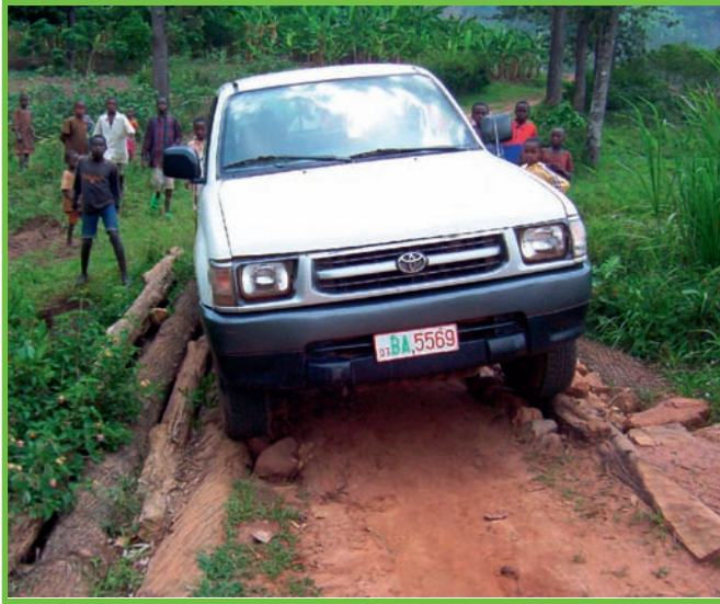
Passaggio su un ponte pericolante
