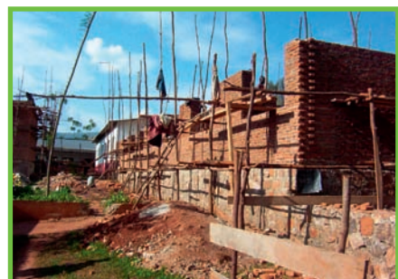
Lavori in corso nella maternità.
