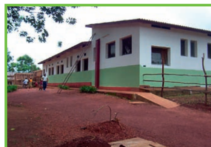
L'ala ristrutturata della chirurgia.
