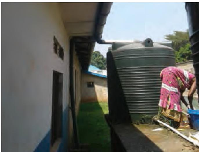
Particolare del collegamento canale - serbatoio.
