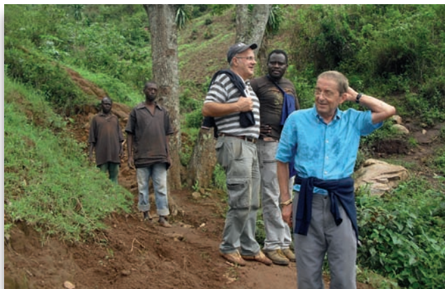
L'ing. Padovan verifica la condotta riparata dell'acquedotto
