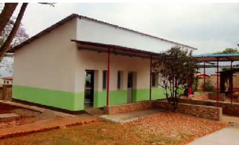
Veduta esterna della Neonatologia a Kiremba
